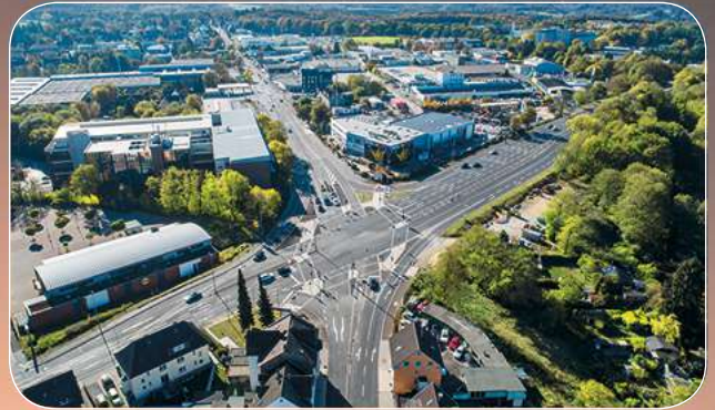
Umbau Straßenkreuzung Trecknase B 229 / B 51
